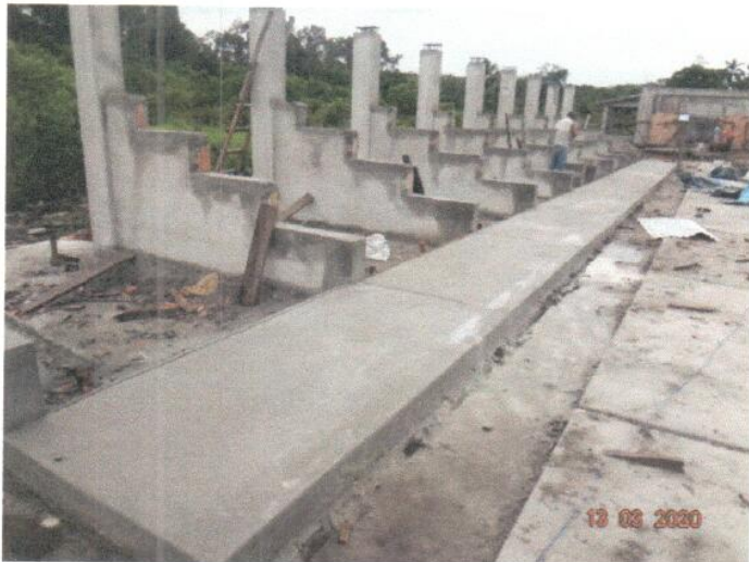
VACEO VEREDA DE MORTERO F'c= 175 KG/CM 2 , E=4" – EN TRIBUNA DE LOSA DEPORTIVA
