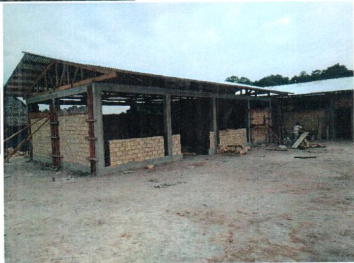
COLOCACION DE COBERTURA DE TECHO MODULO COMEDOR PRIMARIA
