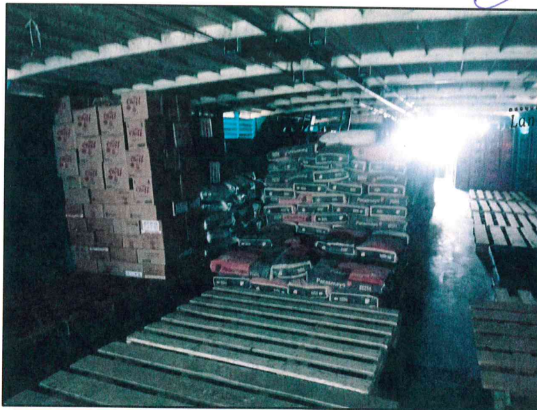
FOTO N°08: OTRA TOMA DONDE SE OBSERVA LA EJECUCION DE LOS TRABAJOS DE TRANSPORTE DE MATERIALES DESDE YURIMAGUAS HASTA EL LUGAR DE LA OBRA (PIE DE OBRA).
