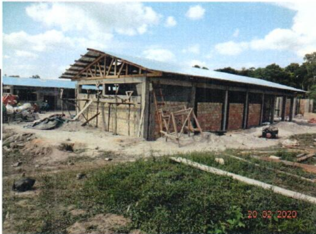
MONTAJE COBERTURA DE TECHO MODULO ADMINISTRACIÓN PRIMARIA
