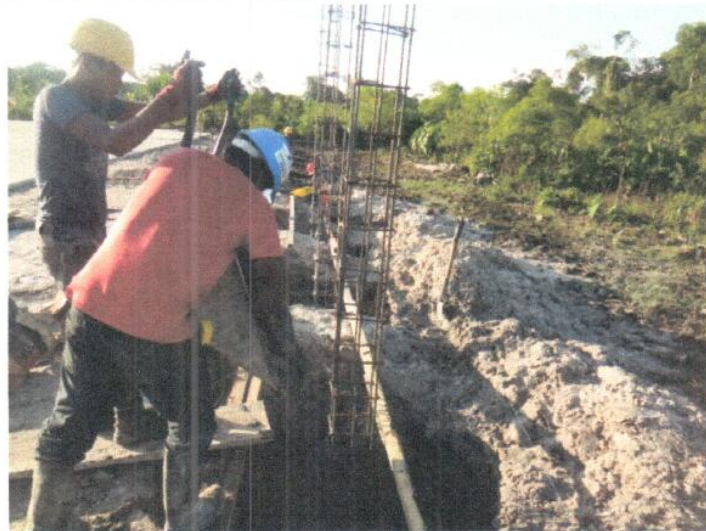
VACEO DE MORTERO F'c= 210 KG/CM 2 PARA ZAPATAS DE TRIBUNA EN LOSA DEPORTIVA
