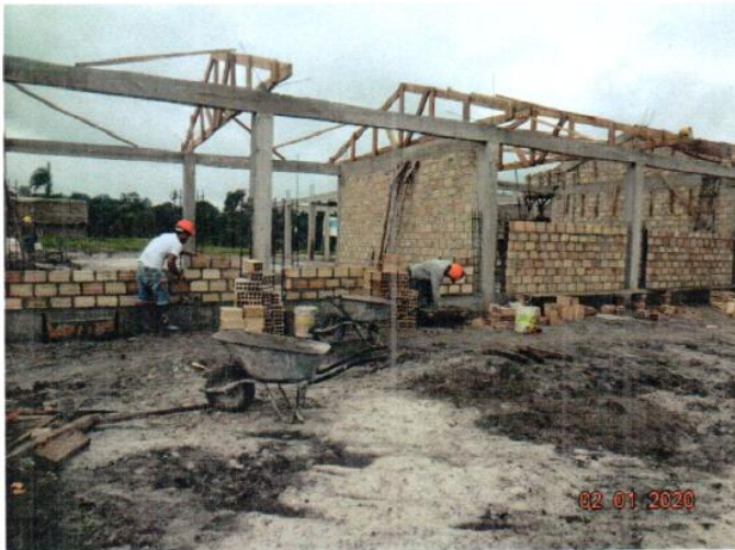
ASENTADO MURO DE LADRILLO C:A=1:5 MODULO 03 AULA
