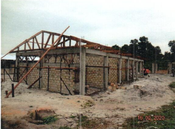
MONTAJE DE TIGERALES 2"X6" MODULO ADMINISTRACIÓN PRIMARIA
