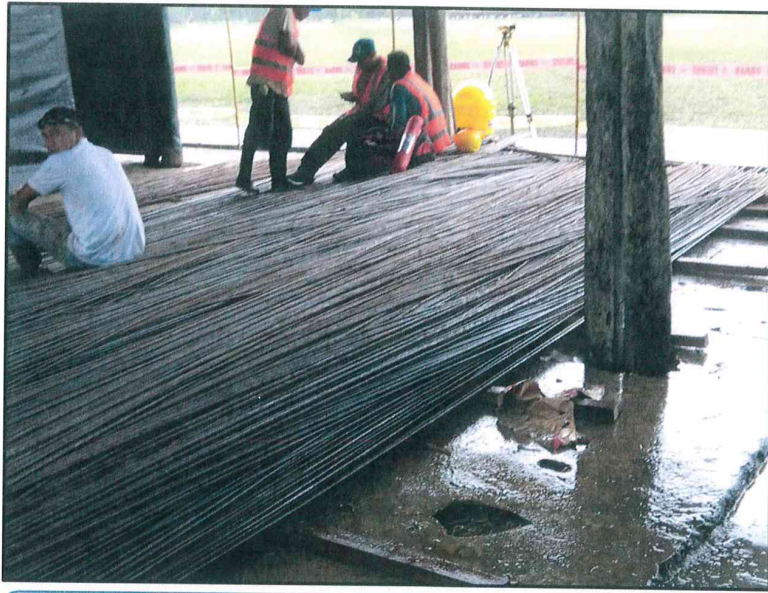
FOTO N°09: SE OBSERVA LOS MATERIALES COLOCADOS EN ALMACEN EN OBRA.
