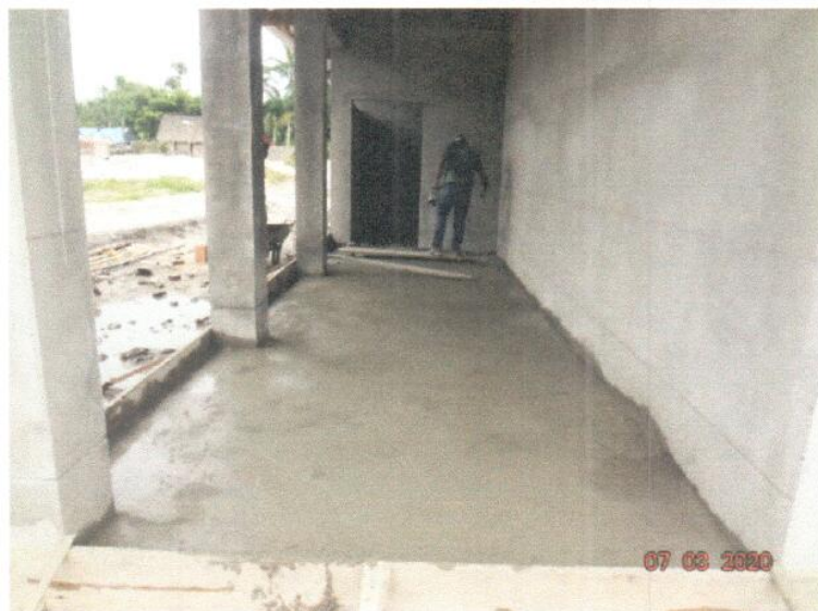
VACEO VEREDA DE MORTERO F'C= 175 KG/CM 2 , E=4" – EN LADO POSTERIOR MODULO ADMINISTRACIÓN PRIMARIA
