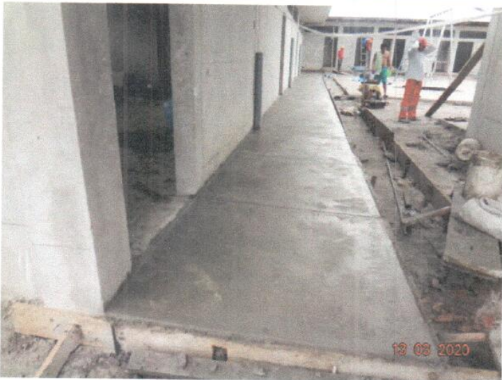
VACEO VEREDA DE MORTERO F'c= 175 KG/CM 2 , E=4" – EN 03 AULAS MODULO PRIMARIO
