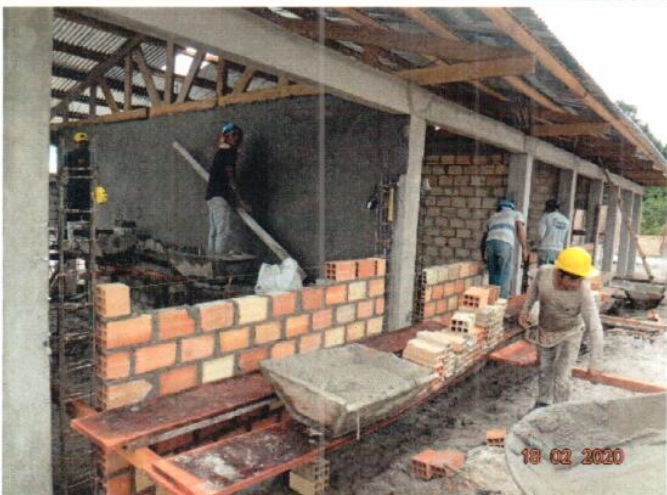
ASENTADO MURO DE LADRILLO Y TARRAJEO C:A=1:5 MODULO ADMINISTRACIÓN PRIMARIA
