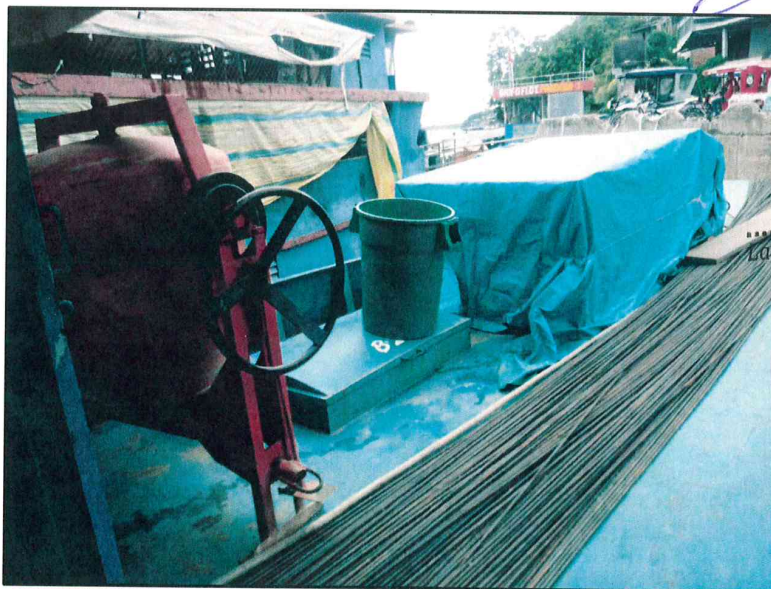
FOTO N°06: SE OBSERVA LA EJECUCION DE LOS TRABAJOS DE TRANSPORTE DE MATERIALES DESDE YURIMAGUAS HASTA EL LUGAR DE LA OBRA (PIE DE OBRA).
