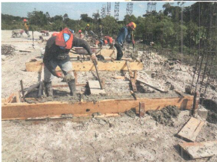
VACEO DE MORTERO F'c= 175 KG/CM 2 PARA SOBRECIMIENTO DE TRIBUNA EN LOSA DEPORTIVA
