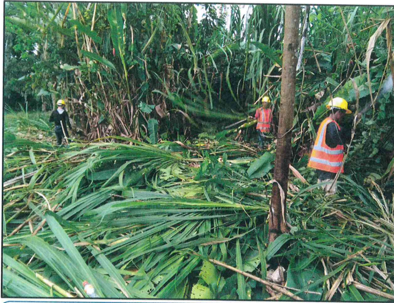
FOTO N°03: SE OBSERVA LA EJECUCION DE LOS TRABAJOS DE LIMPIEZA DE TERRENO MANUAL.
