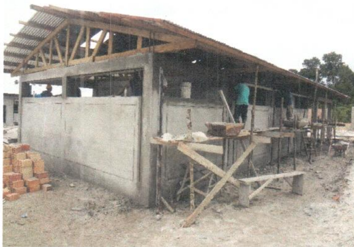
ACABADOS DE DERRAMES C:A=1:5 DE VENTANAS EN MODULO ADMINISTRATIVO PRIMARIA
