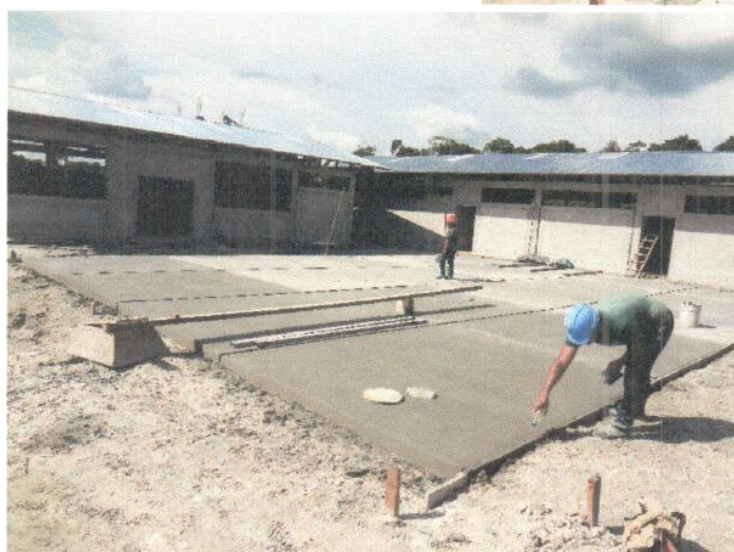
ACABADOS MORTERO EN PATIO DE FORMACIÓN DEL MODULO PRIMARIA
