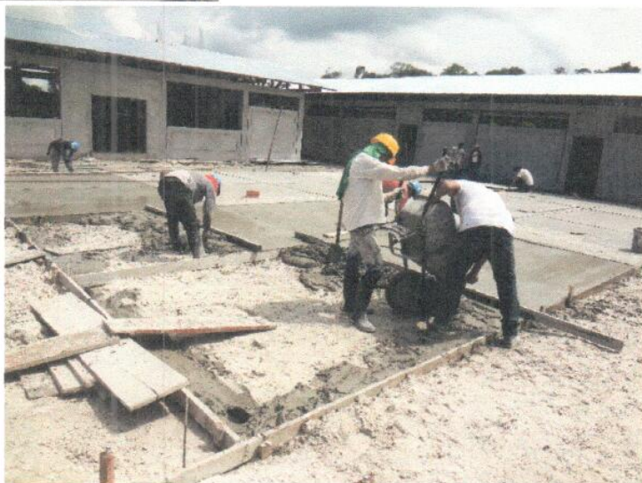
VACEO DE MORTERO F'c= 175 KG/CM 2 EN PATIO DE FORMACIÓN DEL MODULO PRIMARIA
