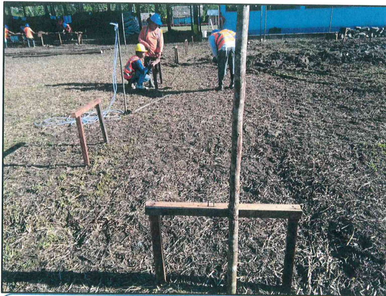
FOTO N°05: SE OBSERVA LA EJECUCION DE LOS TRABAJOS DE TRAZO, NIVELACION Y REPLANTEO PRELIMINAR.
