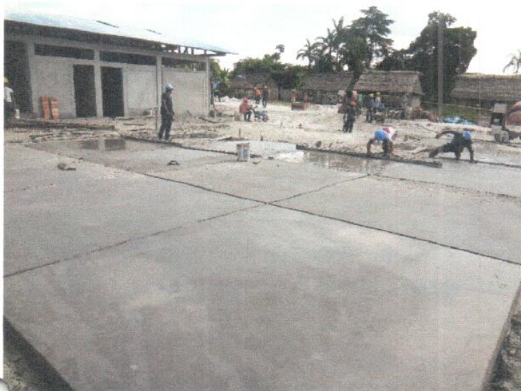
VACEO DE MORTERO F'c= 175 KG/CM 2 EN PATIO DE FORMACIÓN DEL MODULO PRIMARIA
