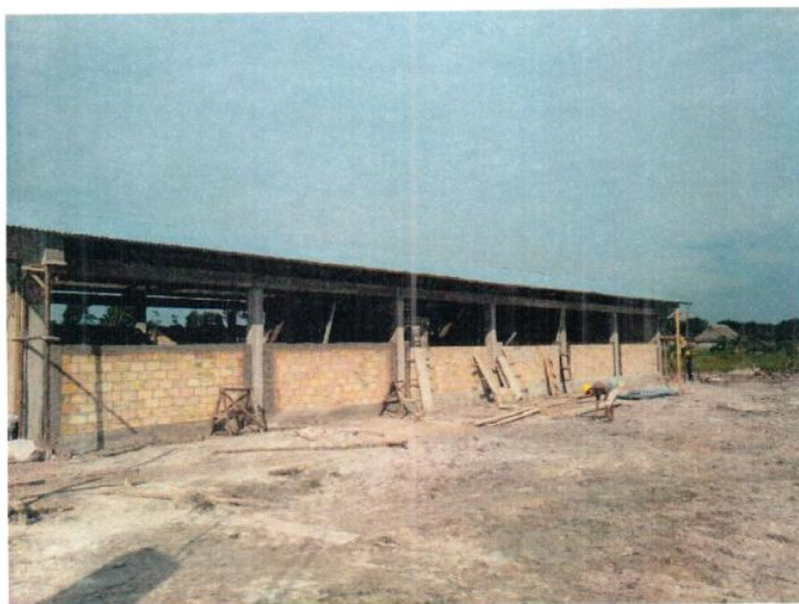
COLOCACION DE COBERTURA DE TECHO MODULO 03 AULAS
