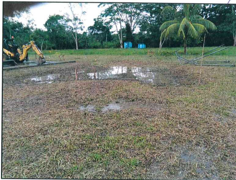
FOTO N°02: EN LA FOTO SE OBSERVA LA EJECUCION DE LOS TRABAJOS DE LIMPIEZA DE TERRENO MANUAL.
