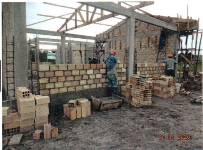
ASENTADO MURO DE LADRILLO C:A=1:5 MODULO 03 AULA
