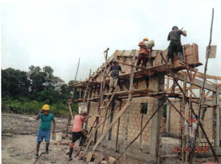
VACEO DE MORTERO F'c= 210 KG/CM 2 EN VIGA TIMPANO MODULO 03 AULA
