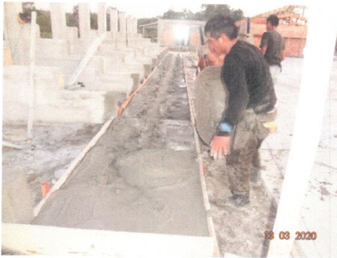
VACEO VEREDA DE MORTERO F'c= 175 KG/CM 2 , E=4" – EN VEREDA FRONTAL DE TRIBUNA
