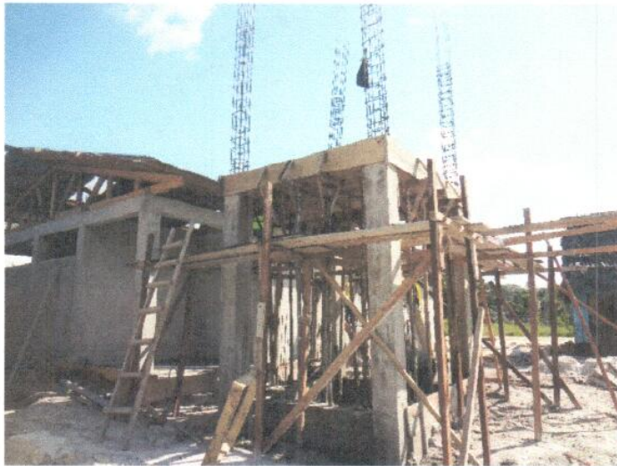
ENCOFRADO ESTRUCTURA DE LOZA MACIZA EN TANQUE ELEVADO
