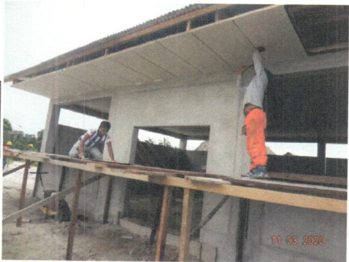
COLOCACIÓN DE CIELORRASO DE SUPERBOARD EN VEREDA FRONTAL DEL MODULO SUM PRIMARIA
