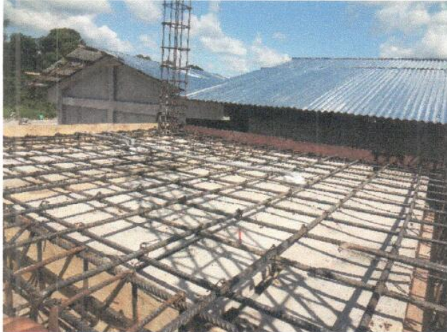
COLOCACIÓN ESTRUCTURA DE ACERO \phi 1/2" PARA LOZA MACIZA DE TANQUE ELEVADO
