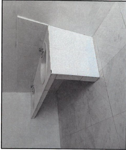
FOTO 16: OTRA VISTA DONDE SE OBSERVA LOS SS.HH. CULMINADA (VISTA INTERIOR).
