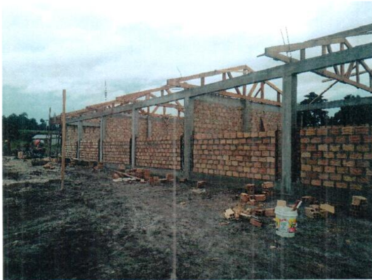
MONTAJE DE TIGERALES 2"X6" EN MODULO 03 AULAS
