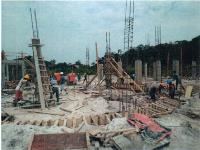
ENCOFRADO DE SOBRECIMIENTO MODULO ADMINISTRACIÓN INICIAL
