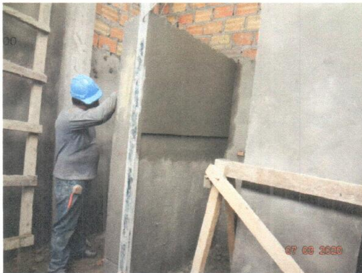
ACABADOS DE TARRAJEO C:A=1:5 DE MUROS, COLUMNAS Y VIGAS DE SS.HH EN MODULO ADMINISTRATIVO PRIMARIA
