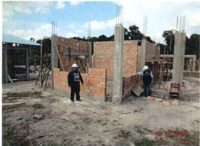
ASENTADO MURO DE LADRILLO C:A=1:5 MODULO ADMINISTRACIÓN INICIAL
