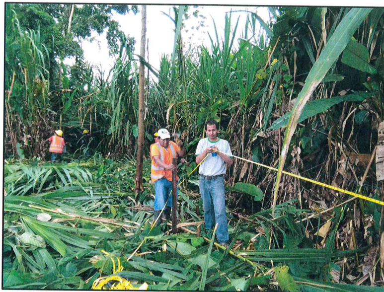
FOTO N°04: OTRA TOMA DONDE SE OBSERVA LA EJECUCION DE LOS TRABAJOS DE LIMPIEZA DE TERRENO MANUAL, Y EL INICIO DE LOS TRABAJOS DE TRAZO Y REPLANTEO PRELIMINAR.
