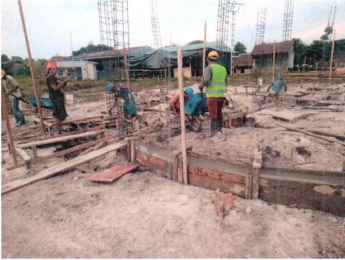
VACEO DE MORTERO F'c=210 KG/CM 2 PARA VIGA DE CIMENTACION MODULO ADMINISTRACIÓN INICIAL
