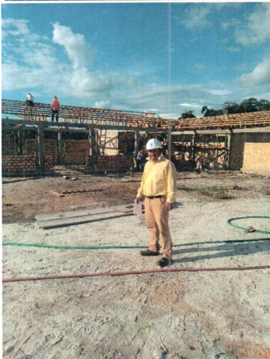
MONTAJE DE CORREAS 2"X3" MODULO COMEDOR PRIMARIA
